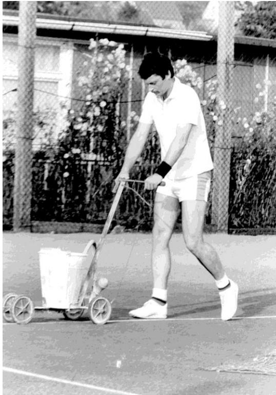
Foto : Nasskreidemaschine im Einsatz
